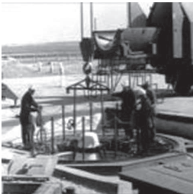
Стыковка ГЧ с ракетой в шахте.
