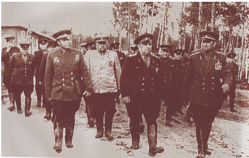
Гречко, Крылов, Шилин...на строящейся БСП
